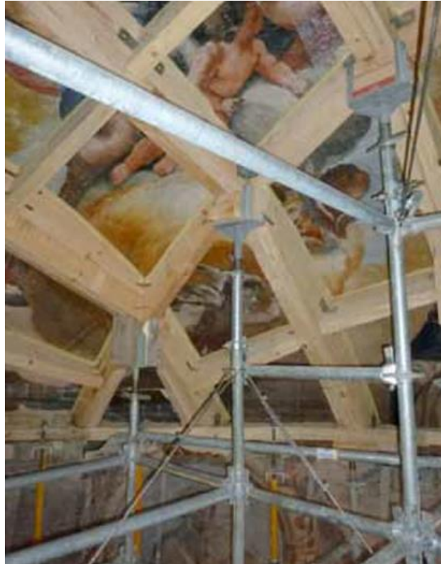
Figura 4.23. Apeo de cúpula con andamio estructural Peri Up Roset. Fuente: Mora Vieyra de Abreu, E. et al, “Evaluación rápida...” [12]
