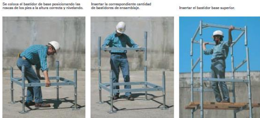
Figura 4.19. Detalle del montaje de Torre ST100.
