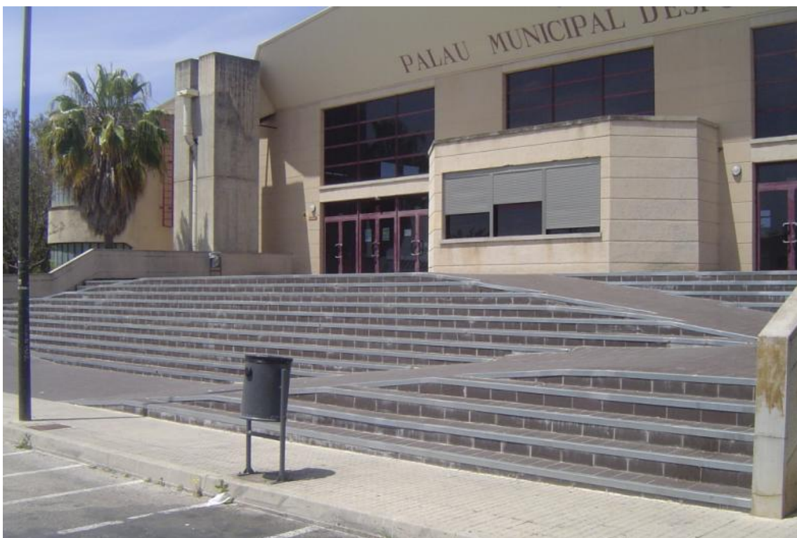
Vista de l'accés principal al Palau d'esports
