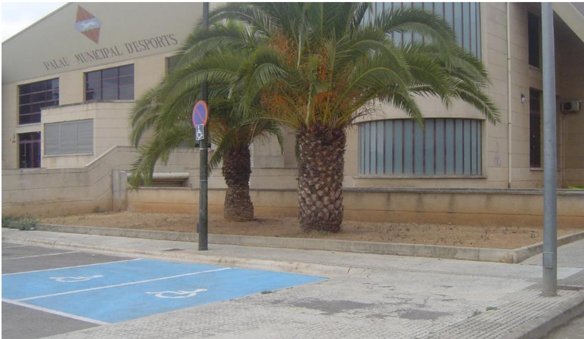
Vista de la pastera on s'instal·larà la rampa de l'itinerari accessible exterior
