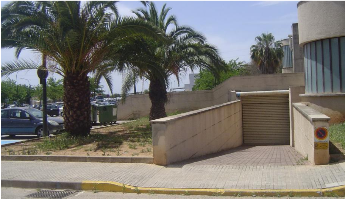
Vista de sortida d'emergència nº 8 i rampa de vehicles
