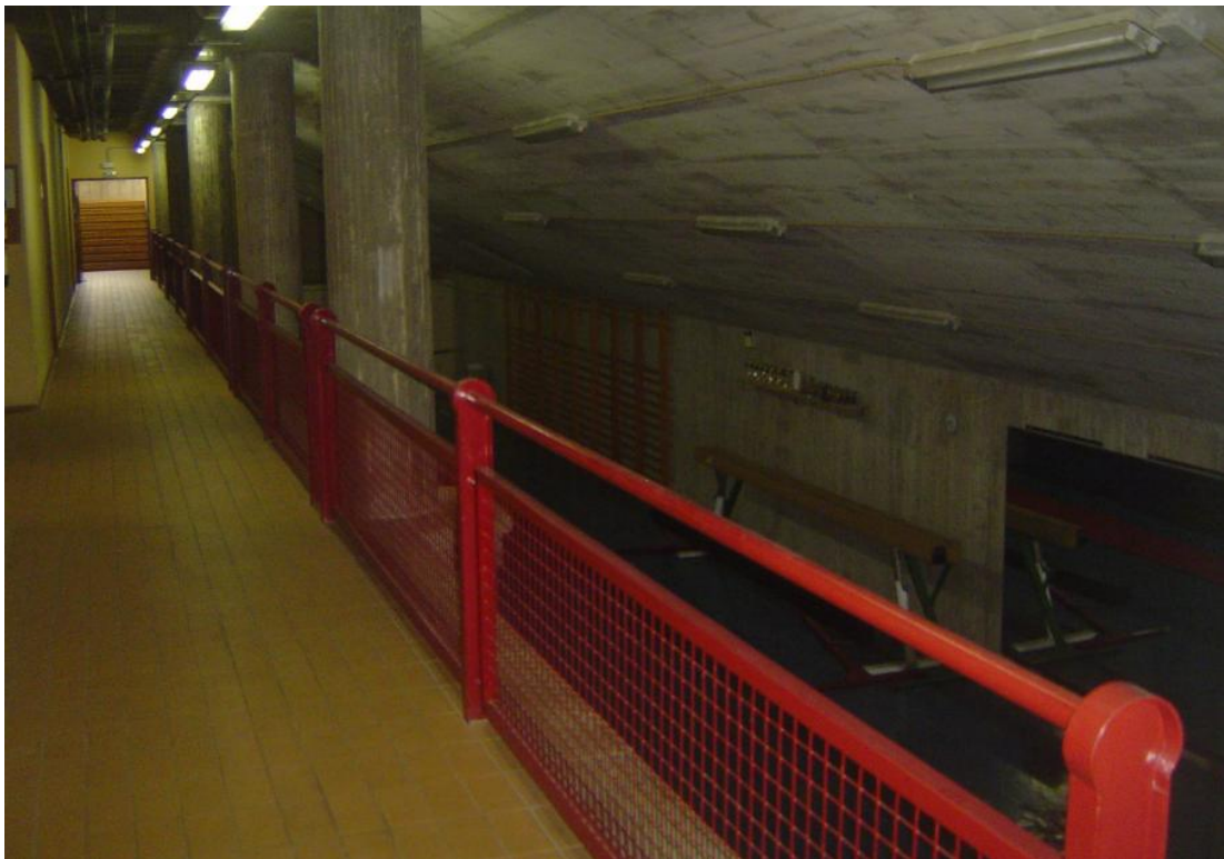
Vista general del passadís planta -1 i la sala de gimnàstica 1 de la planta -2
