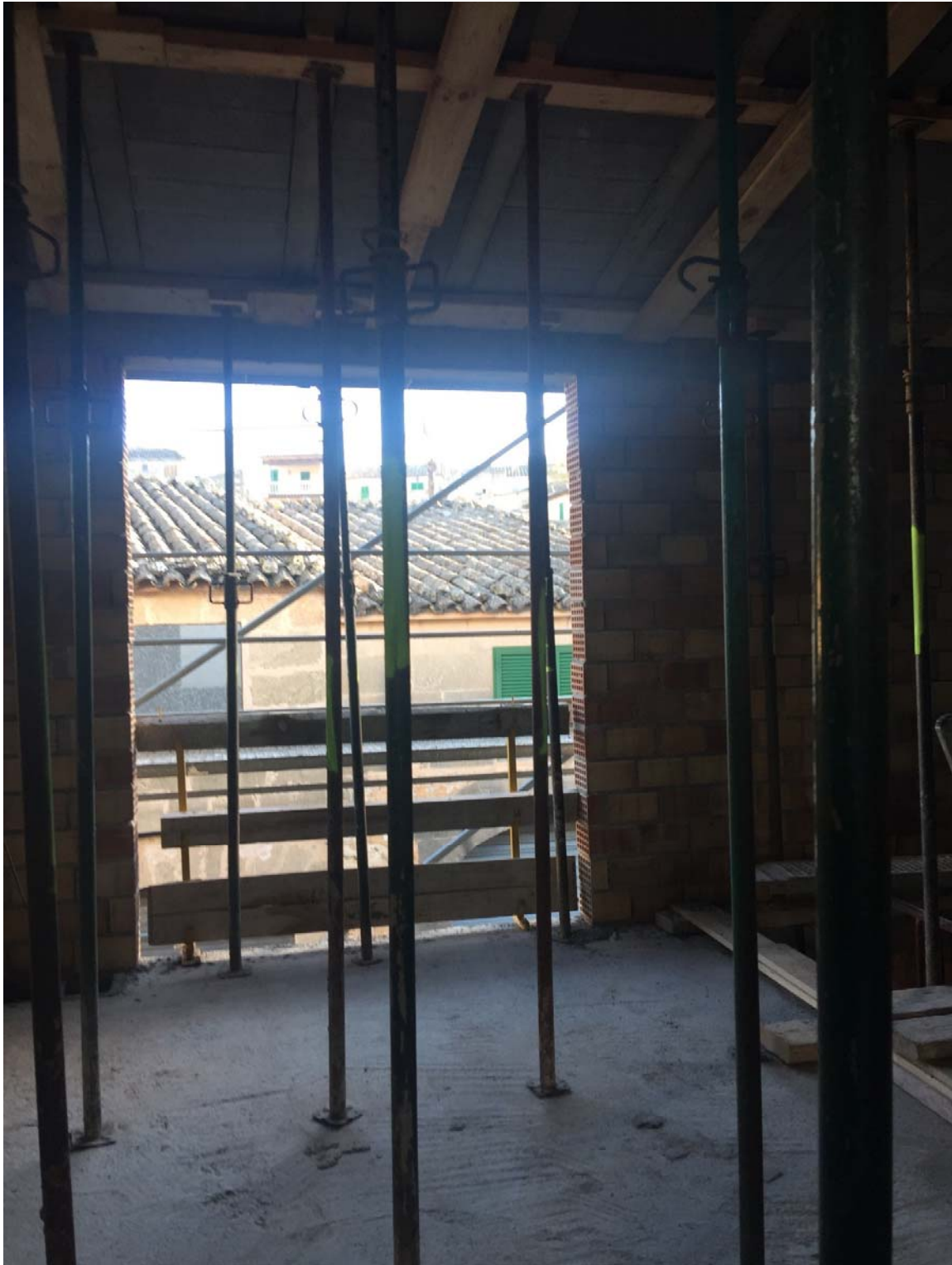
Fotografia 22 – Encofrat forjat inclinat i protecció de buit de façana mitjançant barana
