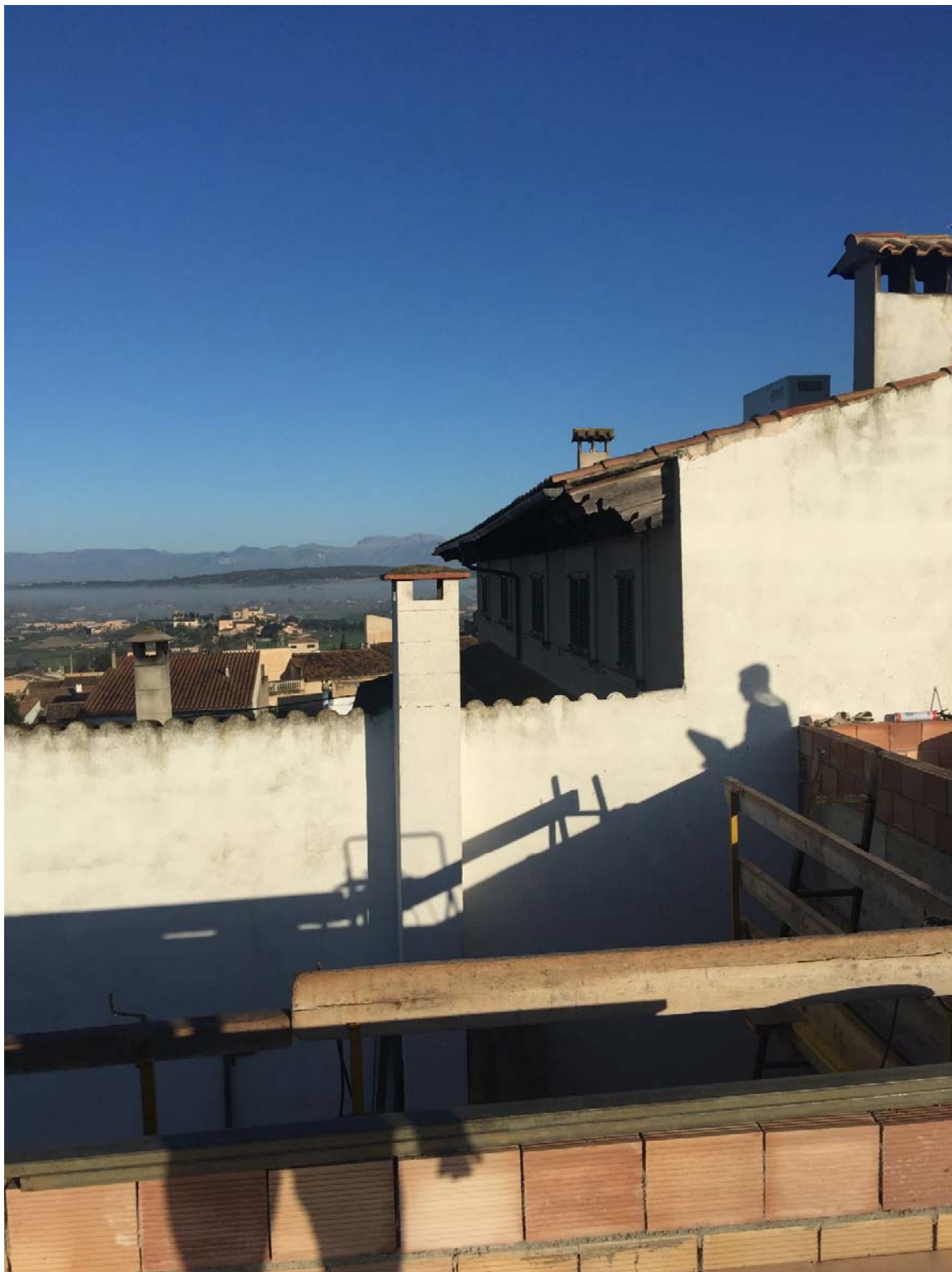
Fotografia 28 – A les cobertes a través d'escala metàl·lica recolzada a l'encofrat
