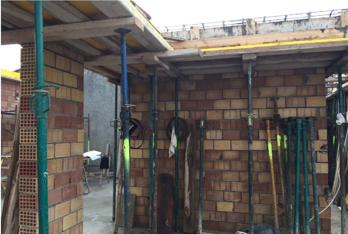
Fotografia 18 – Encofrat del voladiu de façana posterior
