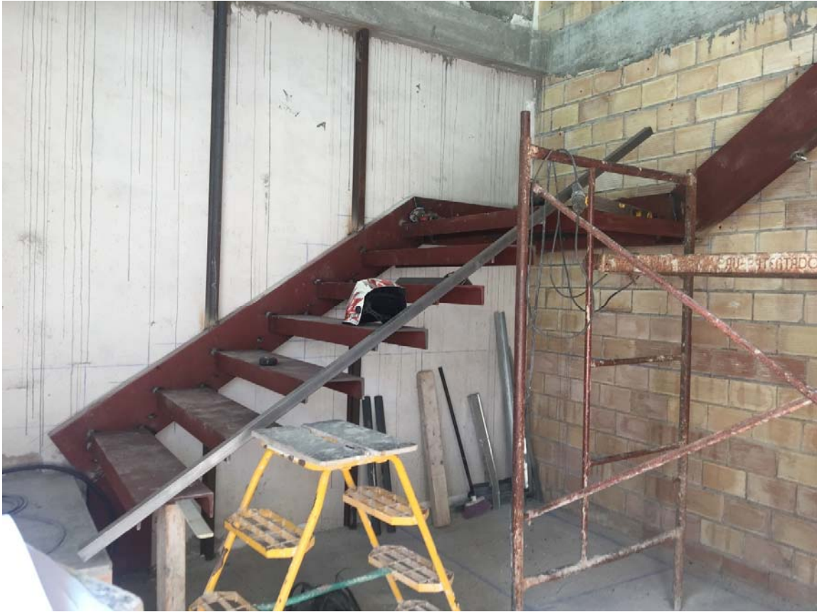
Fotografia 27 – Procés de muntatge de l'escala metàl·lica
