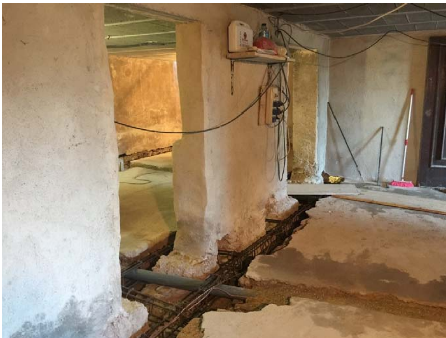
Fotografia 4 – Reforç fonaments correguts lligats mitjançant bigues de 15x25 cm cada 100 cm (Detall B, segons plànols).
