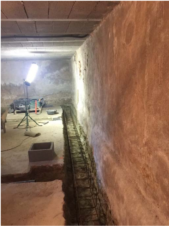
Fotografia 3 – Reforç del fonament del mur de contenció existent de 40x40 cm (Detall A, segons plànols) i excavació per la xarxa de sanejament.
