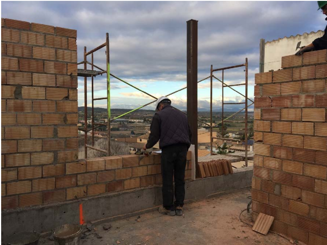
Fotografia 15 – Façana posterior en planta primera
