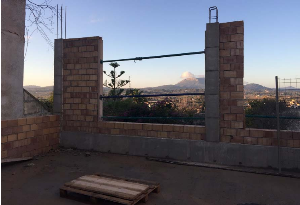
Fotografia 13 – Jàsena penjada de nova construcció, pilars i tancament al pòrtic posterior
