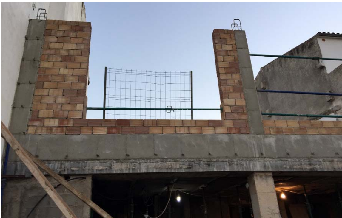
Fotografia 10 – Reforç de jàssena plana existent de 18x45 cm mitjançant una jàssera penjada de 25x45cm
