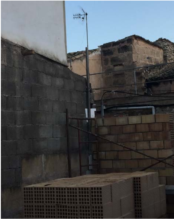
Fotografies 11 i 12 - Tancament estructural de H-16 a la façana principal.
