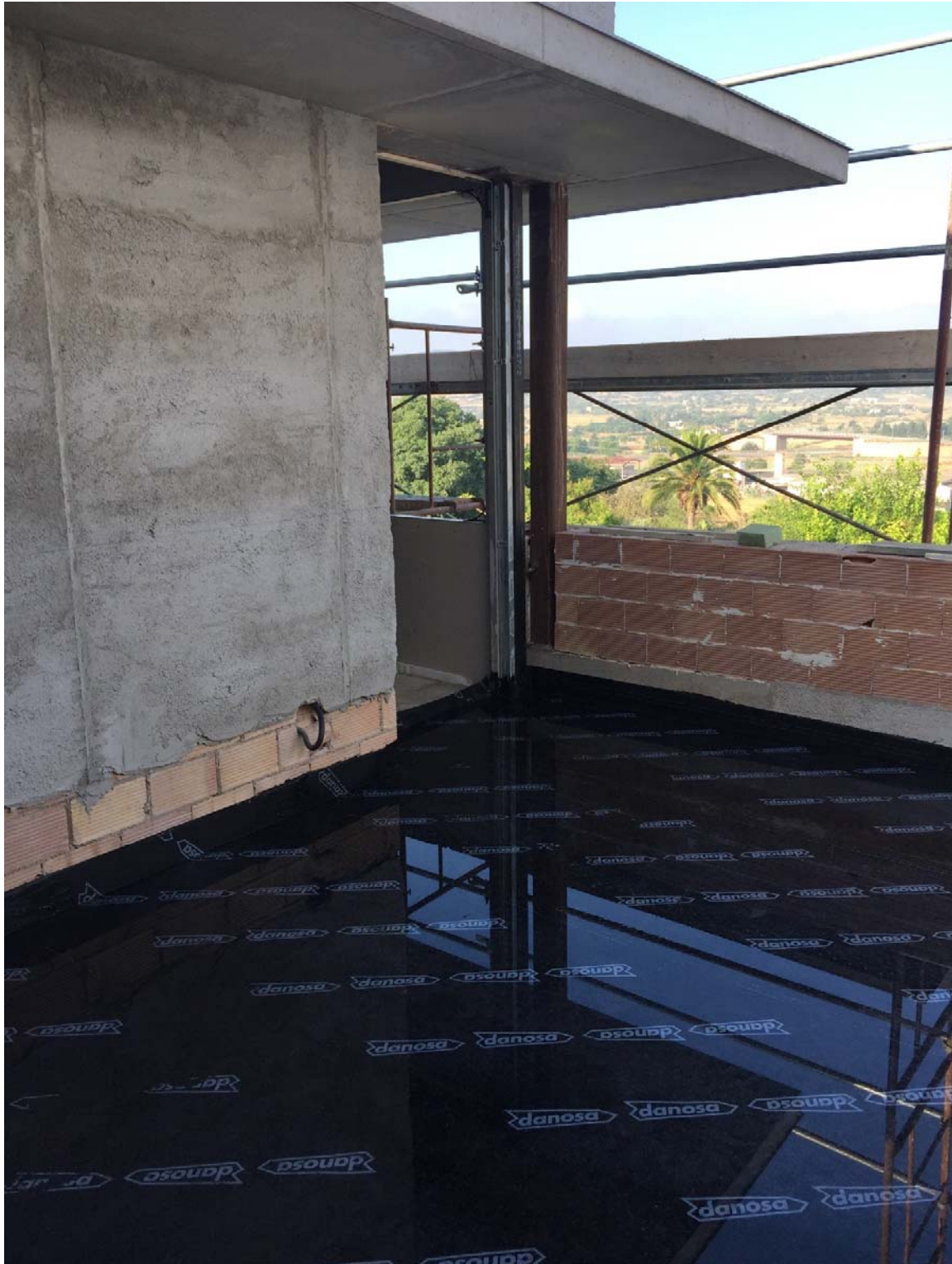
Fotografia 31 – Prova estanqueïtat terrassa planta primera
