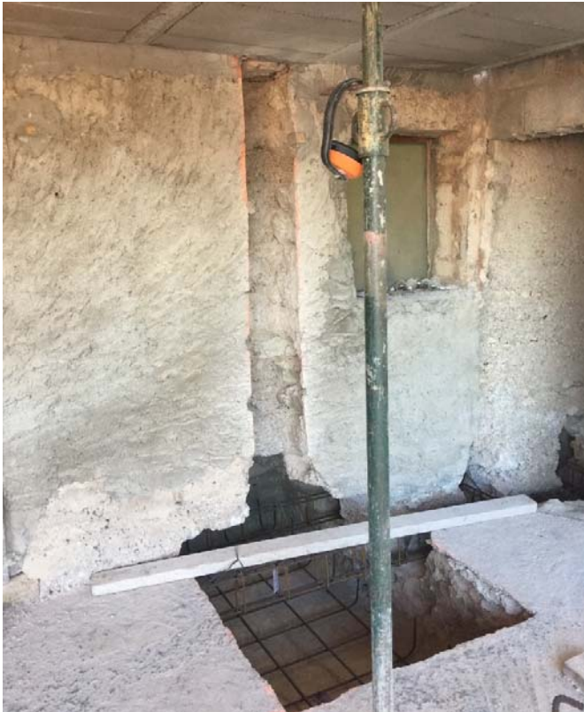
Fotografia 6 – Excavació reforç estructural mitjançant sabata aïllada i pilar metàl·lic i bigues de lligat
