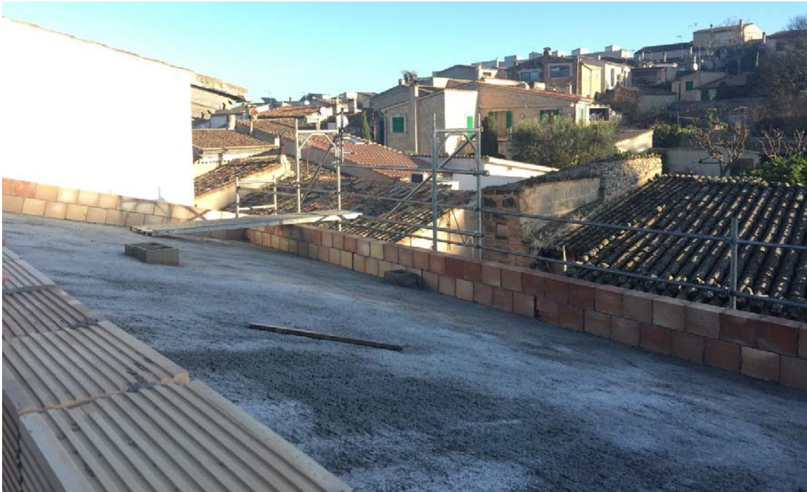
Fotografia 23 – Forjat inclinat amb protecció perimetral amb bastides normalitzades.
