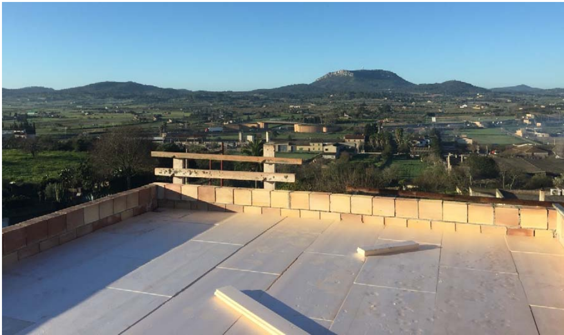
Fotografia 29 – Aïllament de la coberta plana
