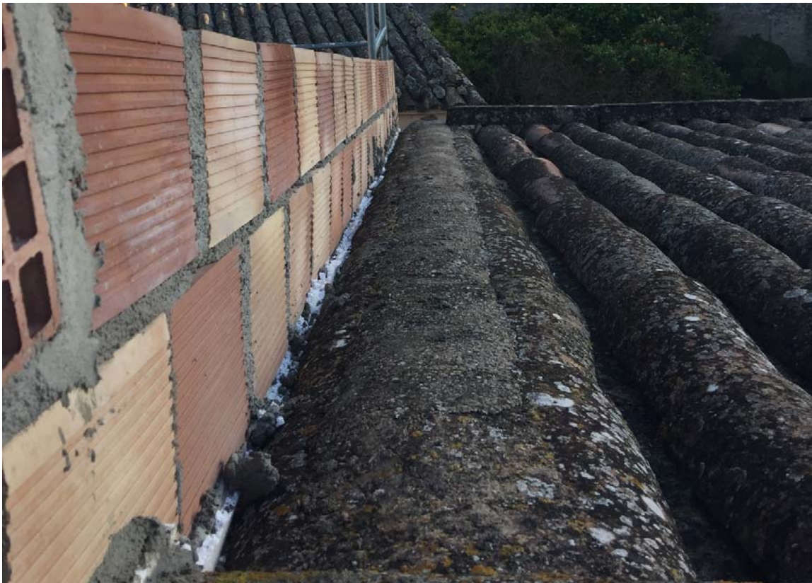
Fotografia 24 – Junta perimetral de porexpan
