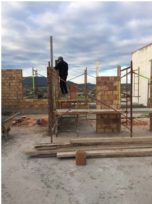
Fotografia 14 – Tancaments i distribució planta primera
