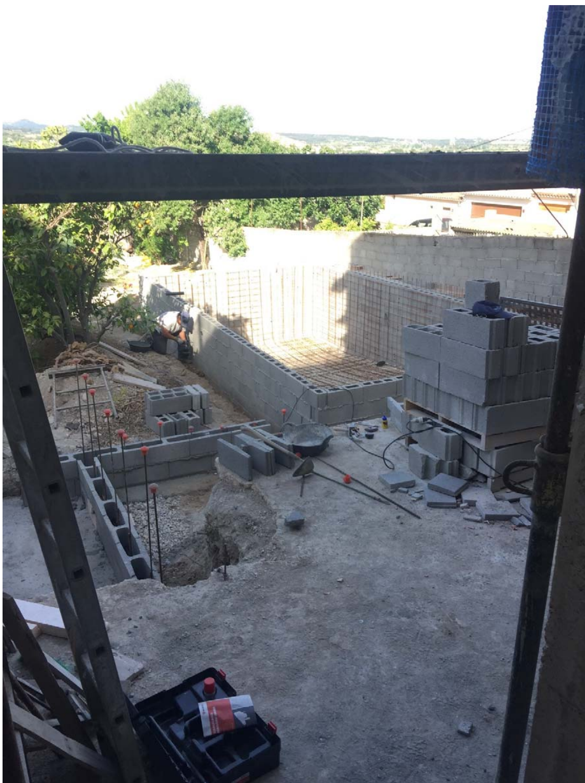
Fotografia 32– Execució contenció piscina i jardí
