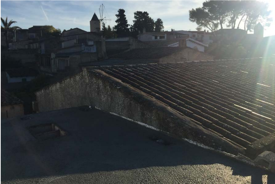
Fotografia 21– Junta perimetral de mitgera
