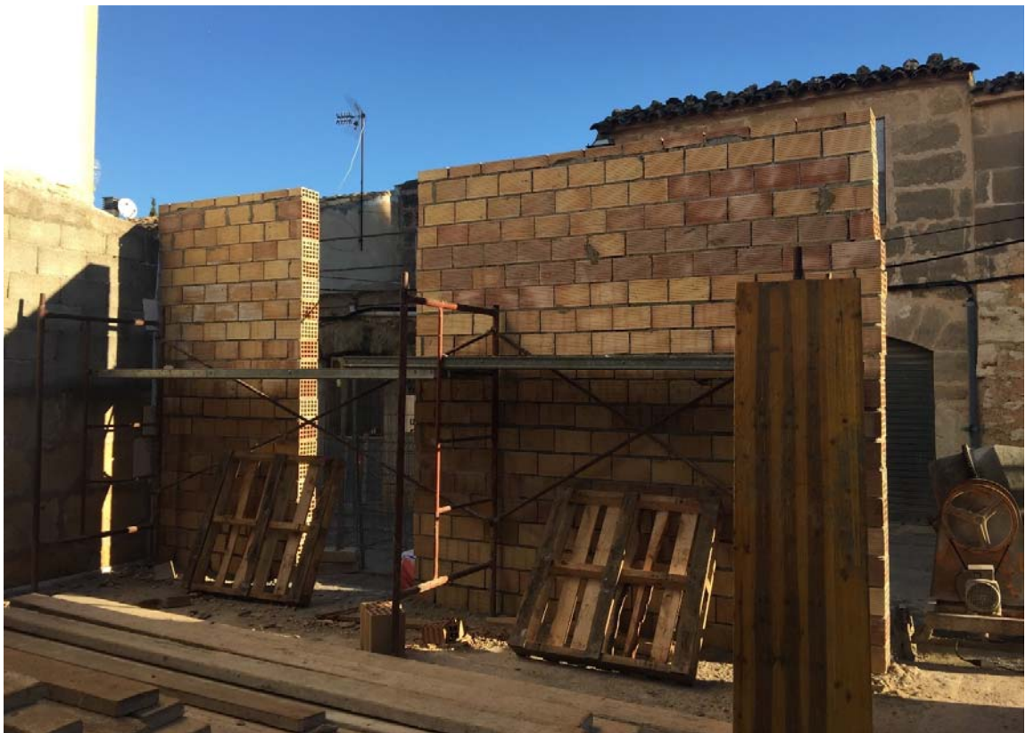
Fotografies 11 i 12 - Tancament estructural de H-16 a la façana principal.
