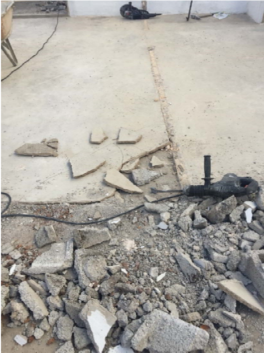
Fotografia 1 – Demolició de coberta i forjat existent
