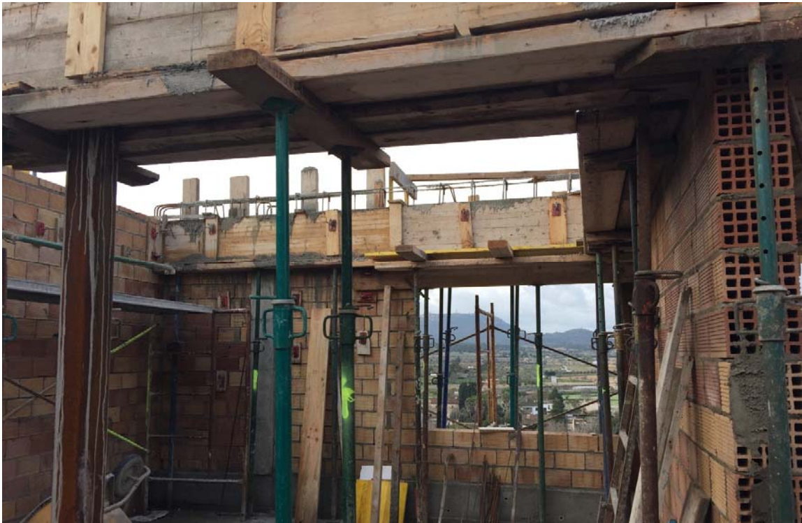
Fotografia 19 – Encofrat de les jàsseres de 25x75 cm i pilars metàl·lics de 120x120 mm
