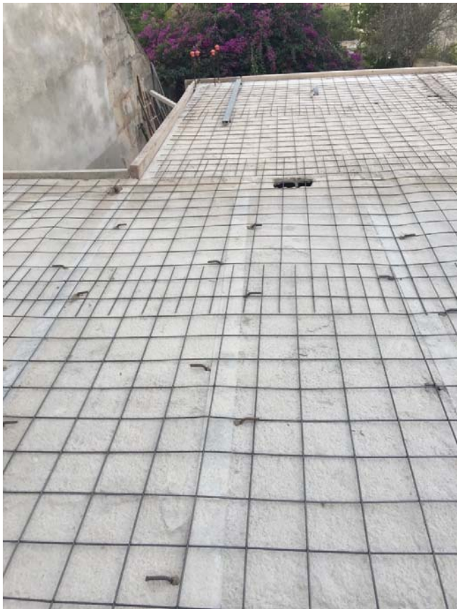
Fotografia 8 – Execució del reforç del forjat existent de sota planta soterrani.
